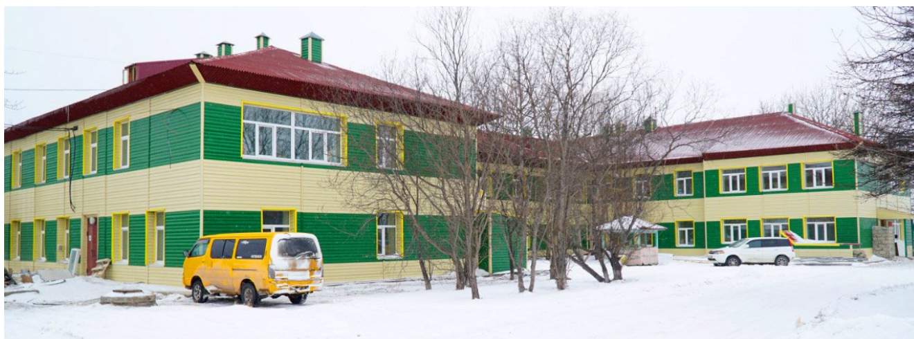
Рисунок 2.20 – здание лечебного корпуса филиала ГБУЗ «МОБ» «Ольская районная больница»
